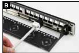
将已完成压接的模块置于背板背部
